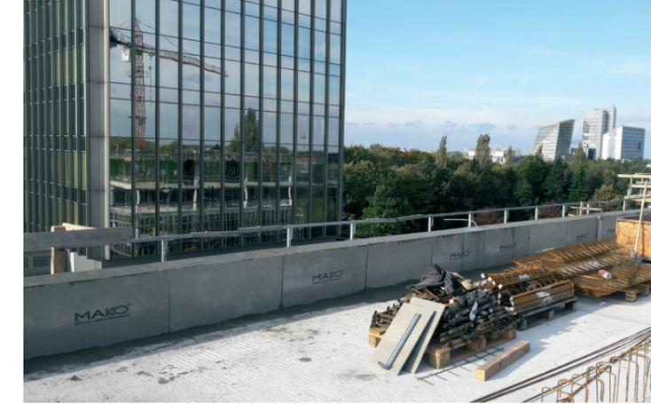
Damit die Handhabung einfach bleibt und die Qualität bei Schalungshöhen von 31 cm bis 50 cm nicht verloren geht, bietet MAKO diese kraftvolle Sturzschalung. Innovativ und effektiv ist dabei, dass die Schalungsplatten durchgehend an den individuell auf Höhe gefertigten U-Bügeln befestigt sind und auch, dass zur Aufnahme des Betondrucks eine integrierte Abspannung geschaffen wurde.
